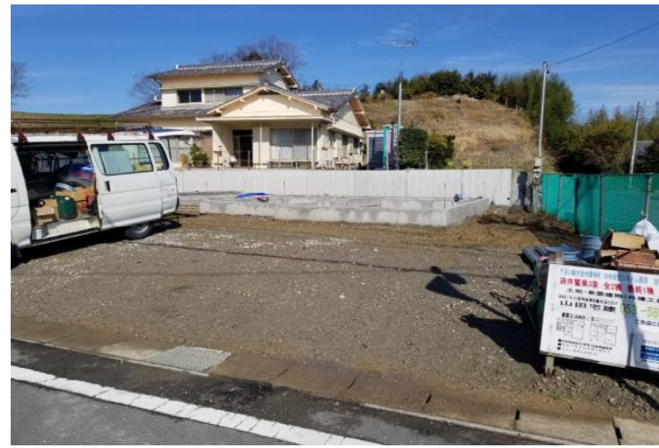
3月6日撮影 基礎工事
