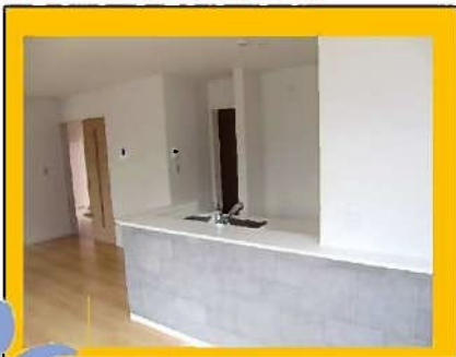
★エコカラット施工例
